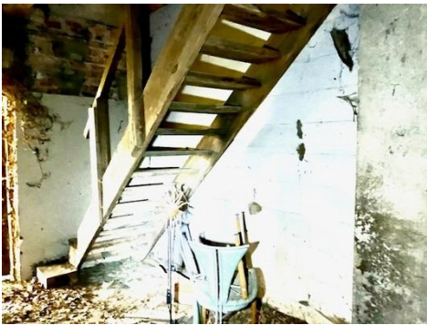
Treppe in der Scheune
