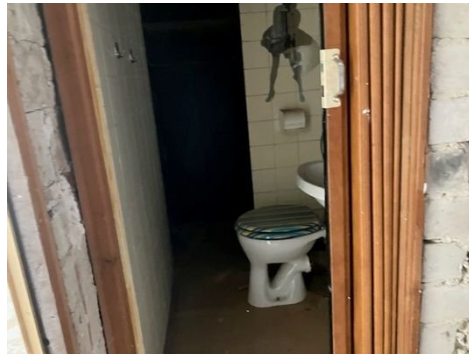
WC im Dachgeschoß
