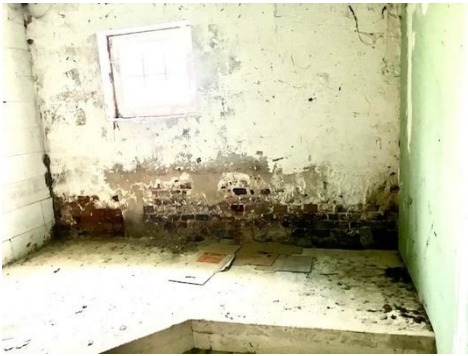
Abstellraum in der Scheune
