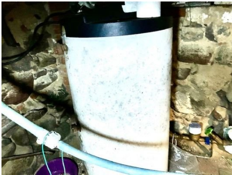
Speicher im Keller
